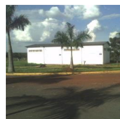
Figura 17. Abrigo de resíduos
