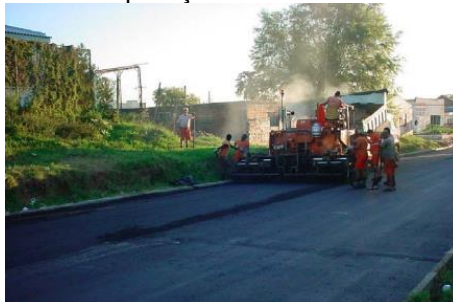
Figura 4. Trecho experimental de aplicação de concreto asfáltico com borracha reciclada
