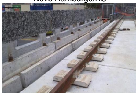
Figura 7. Aplicação de chips de borracha para proteção acústica na obra de ampliação da TRENURB em Novo Hamburgo/RS
