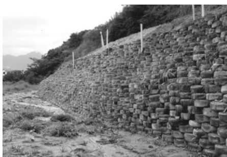
Figura 6. Muro de pneus experimental para a estabilização de encostas
